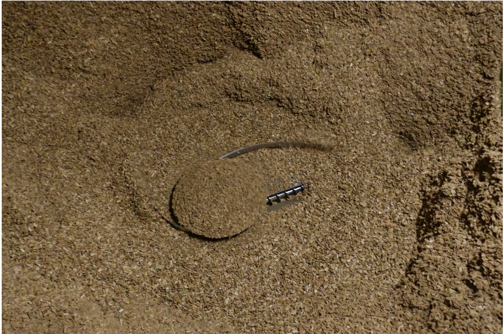
Schnitzelsiloboden mit den zwei Ausräumerarmen und der Schnecke für den Transport nach aussen
